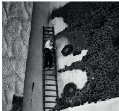
Yves Klein sur le chantier de l'Opéra-théâtre de Gelsenkirchen, en 1958-1959 Photographie de Charles Paul Wilp
